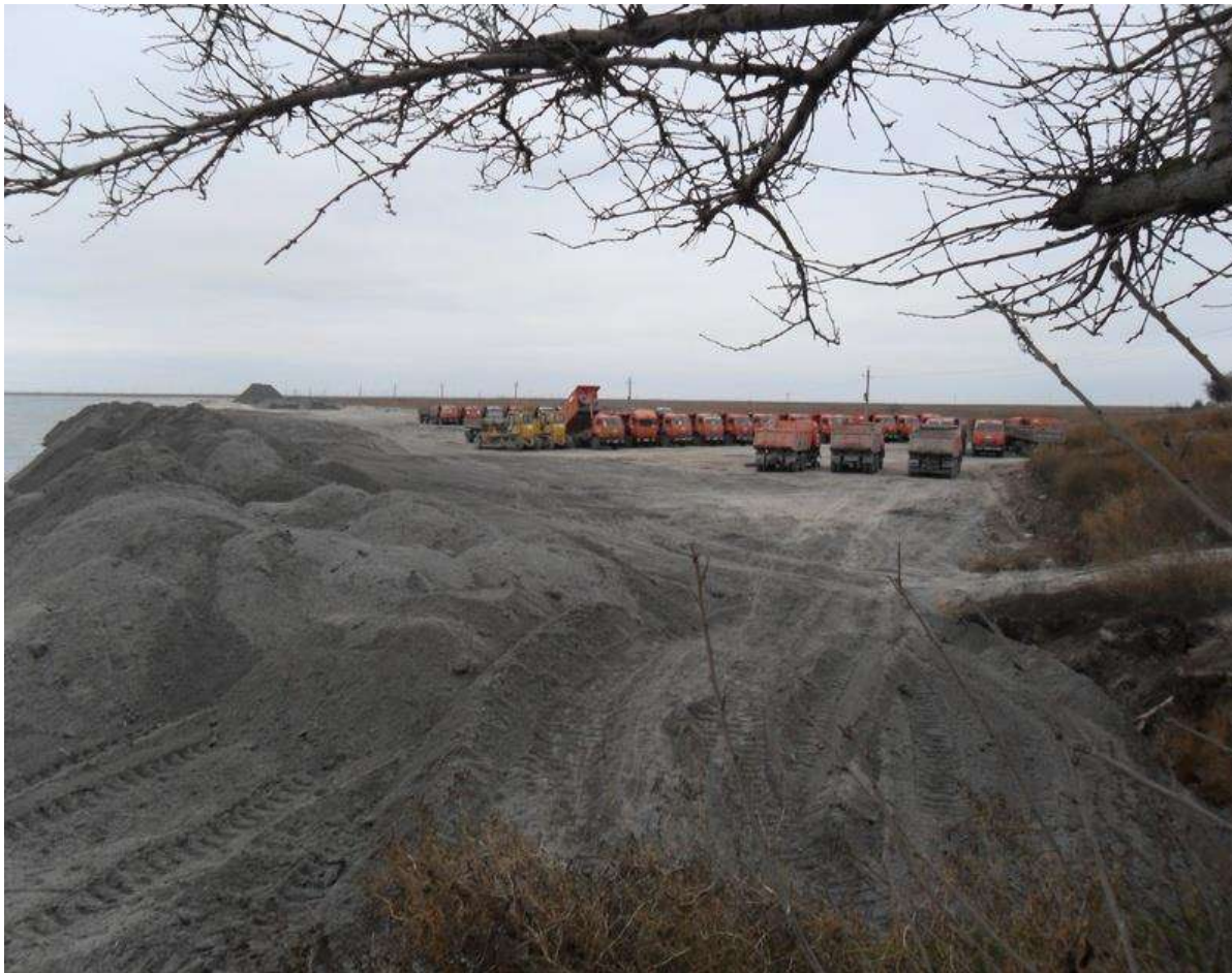
Рис.-3 Строительство дамбы
