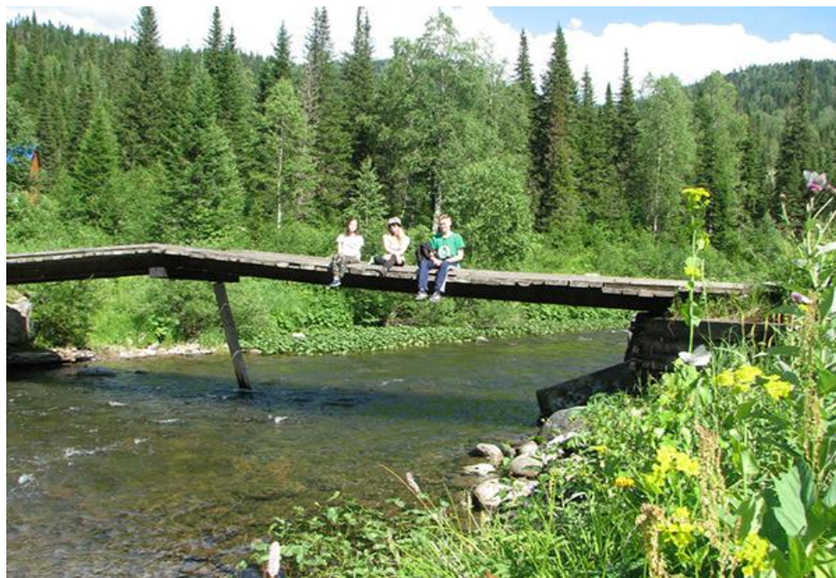
Рисунок 24. Стоянка 5. «Мост у притока реки Томь».
