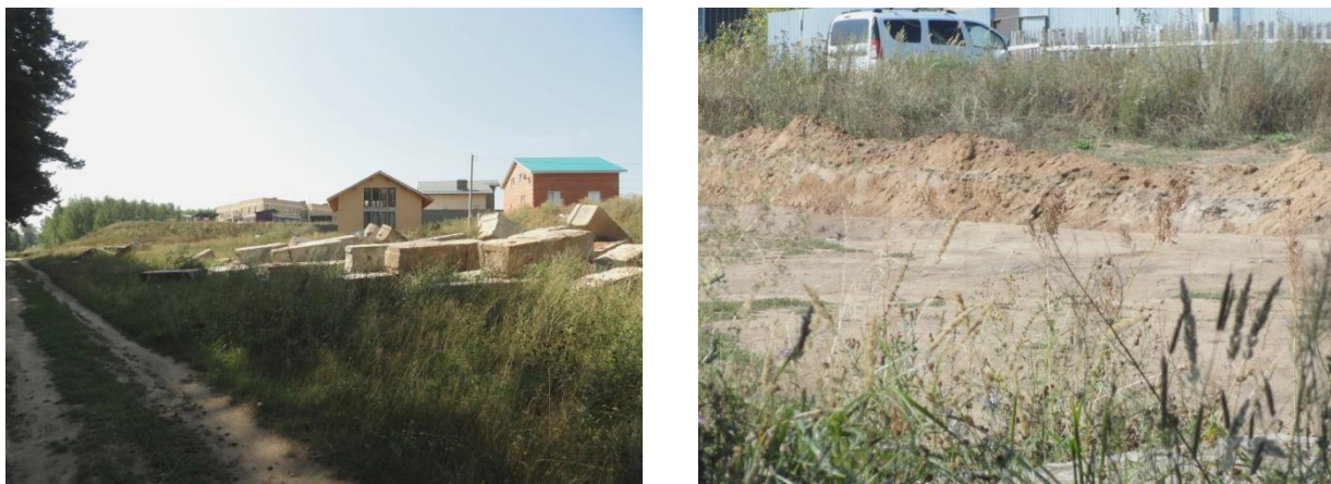
Рис. 12. Захламление поверхности почвы. Перемешивание и засыпание почв в результате строительства.
