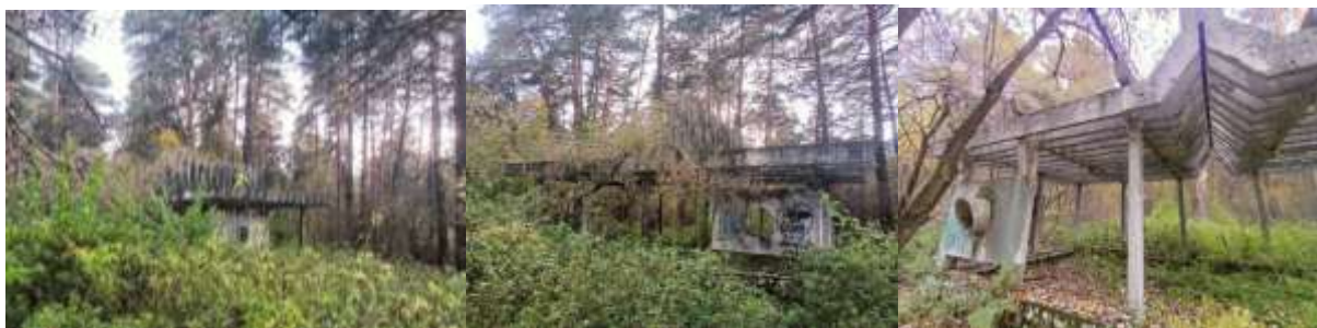
Рисунок 12,13,14-Бетонные остова беседок
