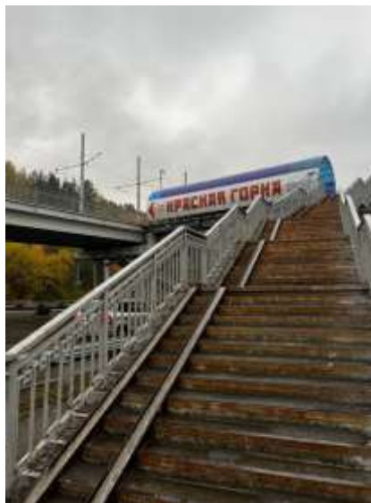
Рисунок 4-Лестница к дорожному кольцу
